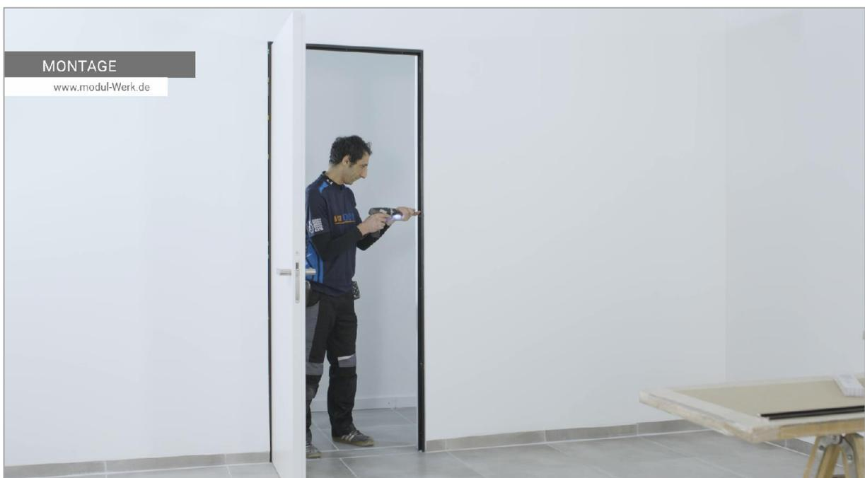
**7.12** Nach erfolgreichem Ausrichten von Türblatt und Zargenteilen montieren Sie die zur Seite gelegten Profildeckel.
