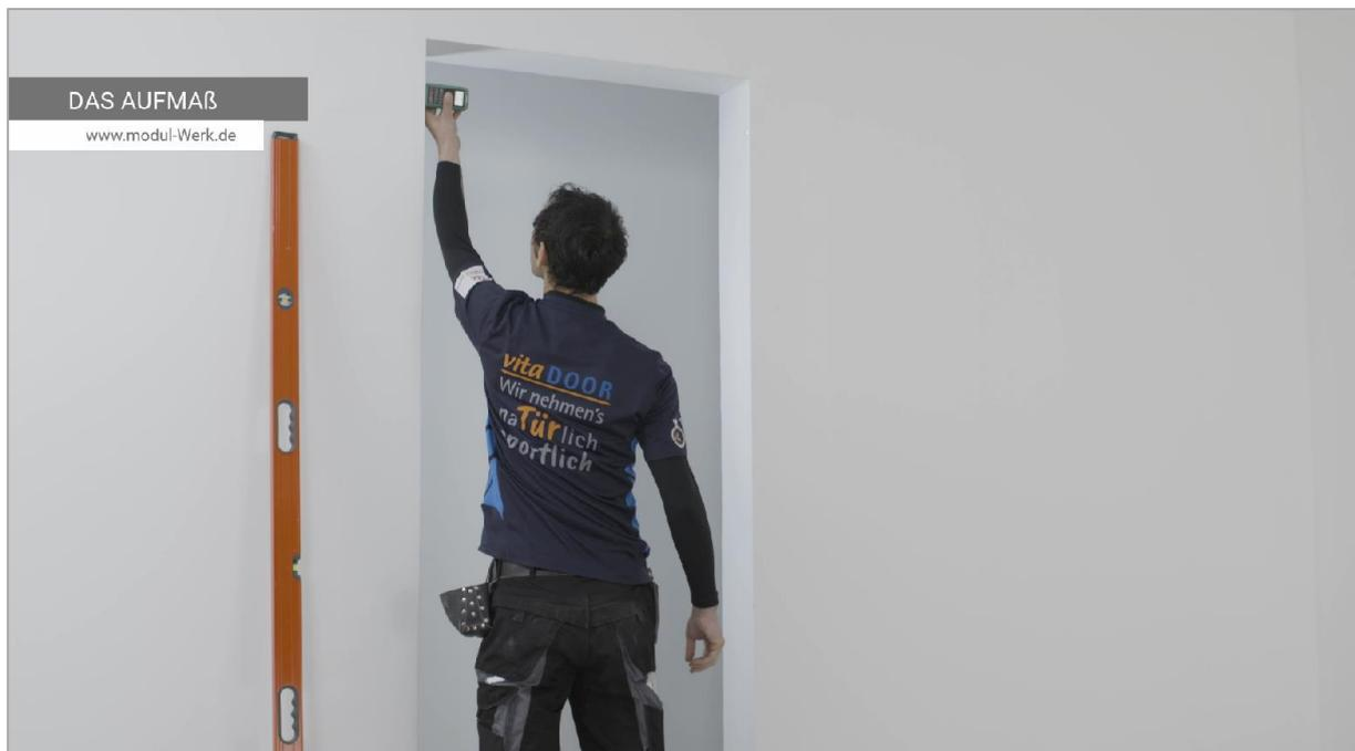
**2.3** Ermitteln Sie die Höhe der Mauerwerksöffnung an zwei Punkten. Beachten Sie, die Stärke des Oberbodens inkl. des benötigten Kleberbetts einzukalkulieren, sofern Sie von der Estrichoberfläche aus messen.
