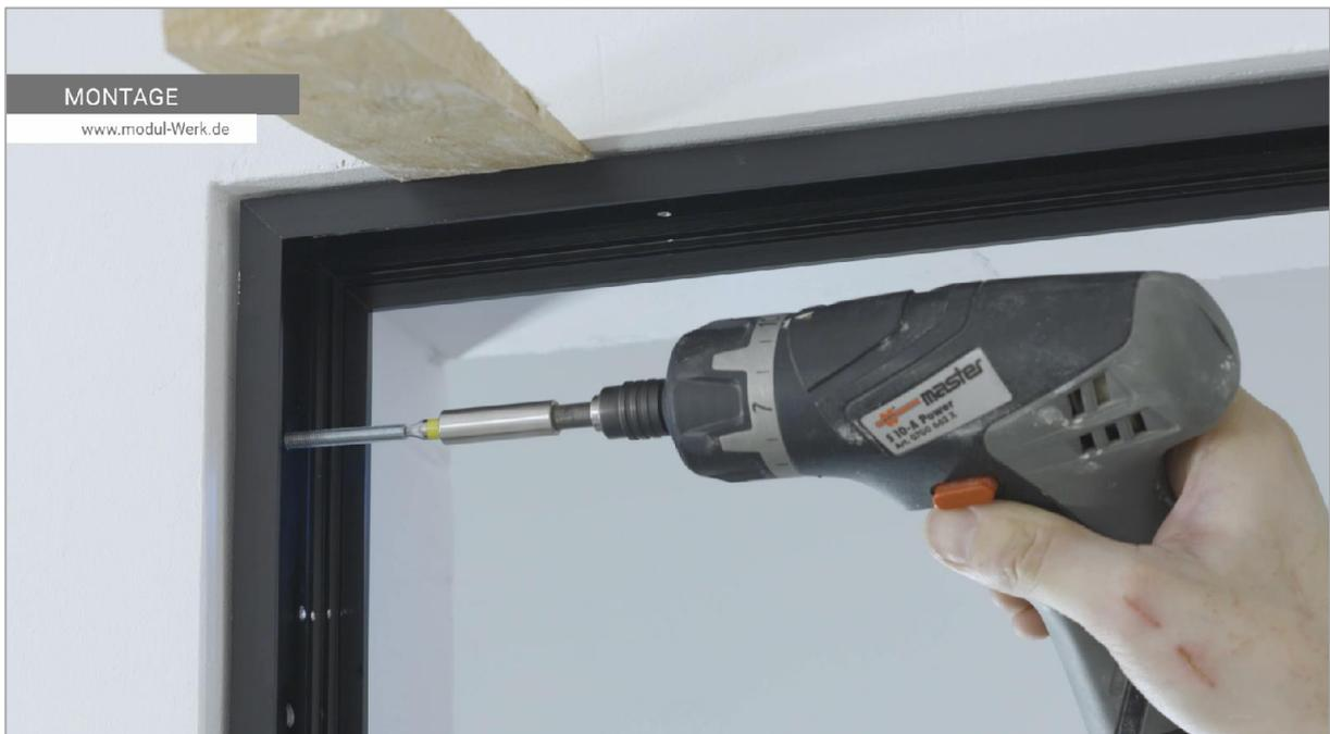
**7.4** Die Zarge des Türsystems modulWERK 1.1 ist auf den Rücksprung gegenüber dem Putz von 10 mm ausgelegt. Sollten Toleranzen in der Lotrechtigkeit der Wandoberfläche auftreten, sind diese in Abhängigkeit der baulichen Gegebenheiten zu berücksichtigen.
