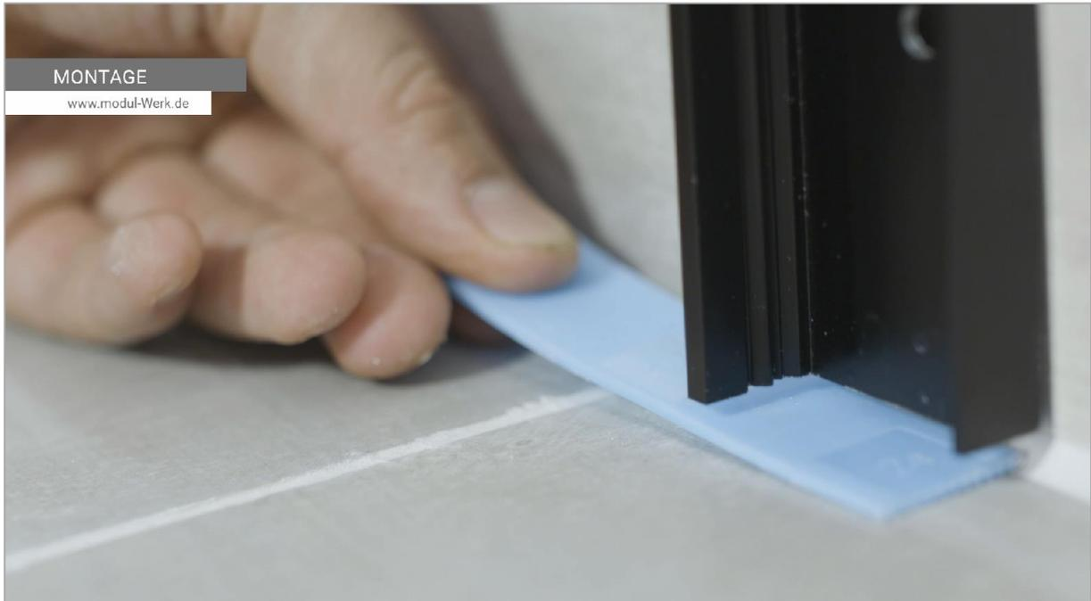
**7.3** Fixieren Sie die Zarge und richten diese in der Höhe aus, indem Sie das Zargenquerstück in Waage bringen. Verwenden Sie dafür die mitgelieferten Schrauben und „klemmen“ Sie somit das Zargenquerstück in der Leibung.
