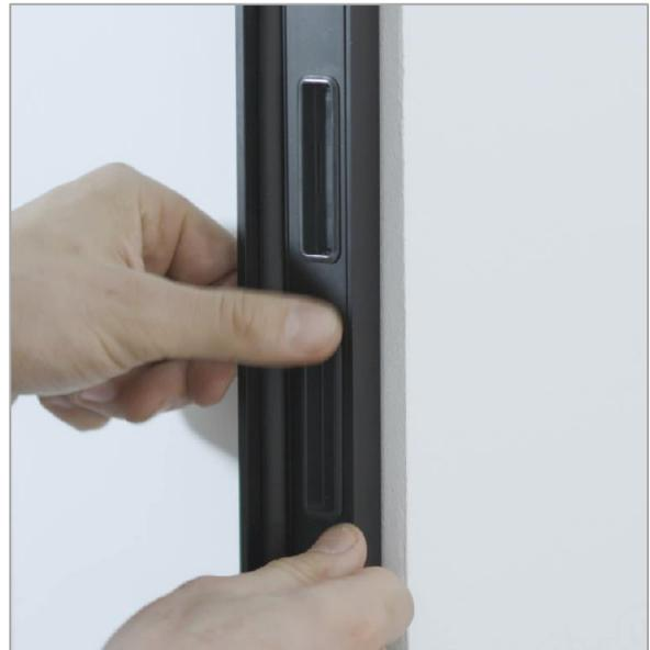
**7.14** Damit besonders reverse öffnende Türen noch während der Bauphase beim Öffnen durch die Leibung nicht beschädigt werden, verwenden Sie zum Schutz die beigefügten Puffer.
